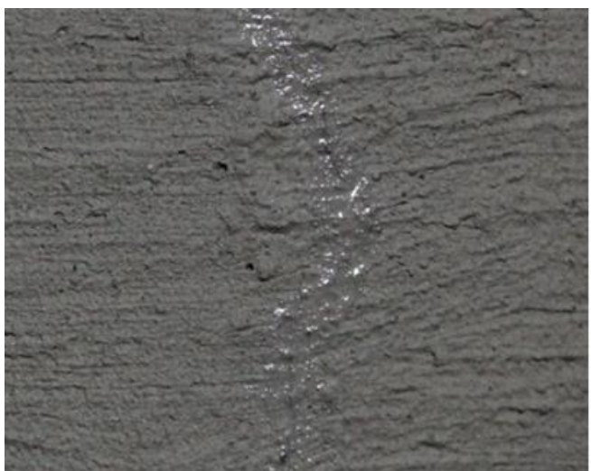
Foto 2. Allmähliche Befeuchtung der Abdichtungsschicht im Bereich des Risses.
